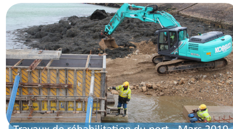
Travaux de réhabilitation du port - Mars 2019
